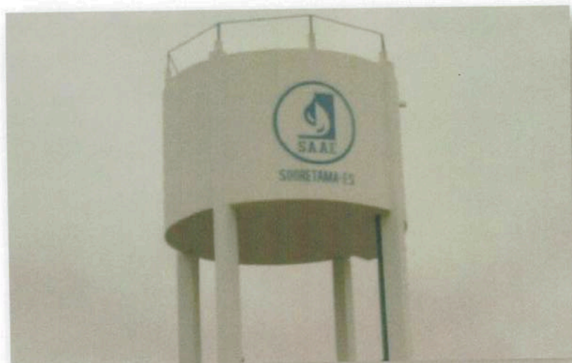
Figura 16: Reservatório com capacidade de 100 m 3 .
