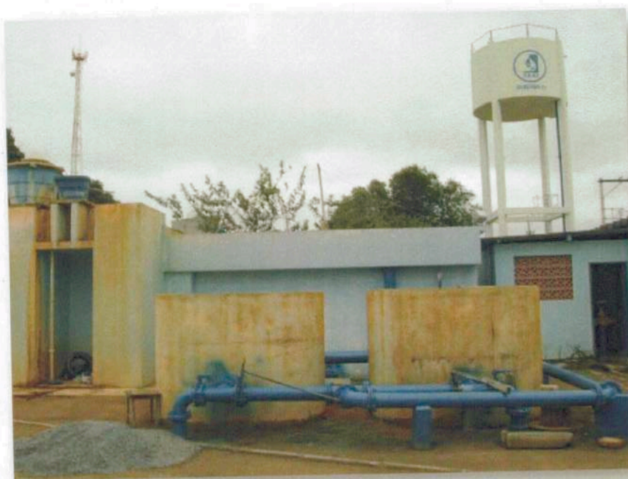
Figura 11: Vista geral da ETA.
