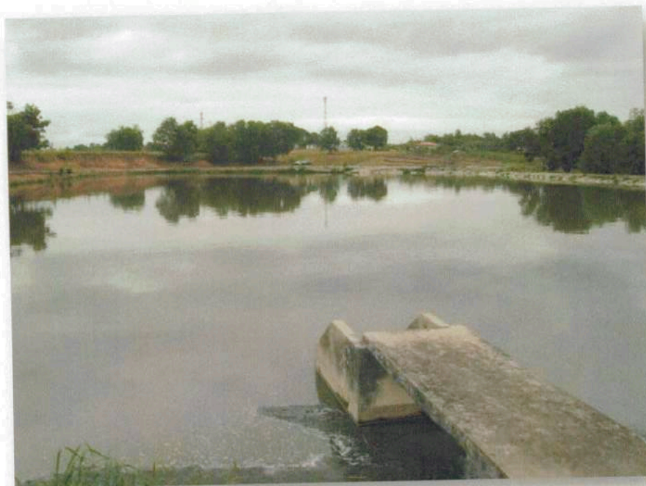
Figura 18: Vista geral da Estação de Tratamento de Esgoto.
