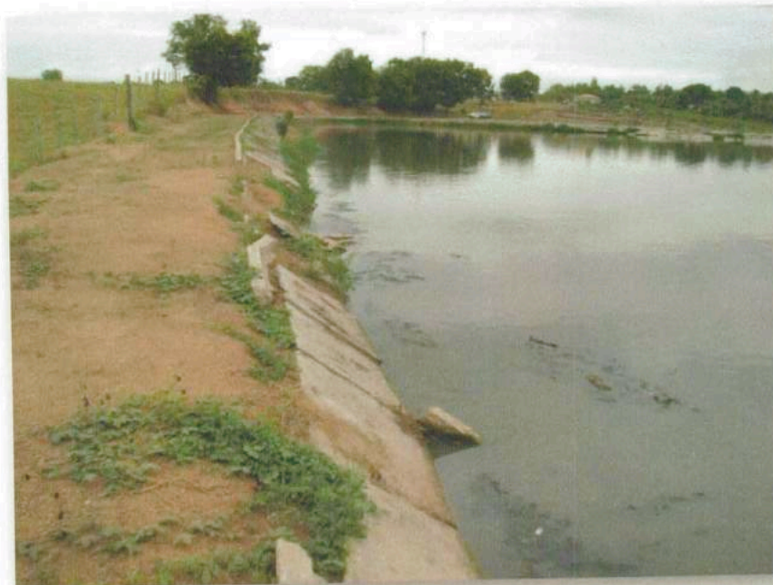
Figura 19: Taludes da Estação de Tratamento de Esgoto
